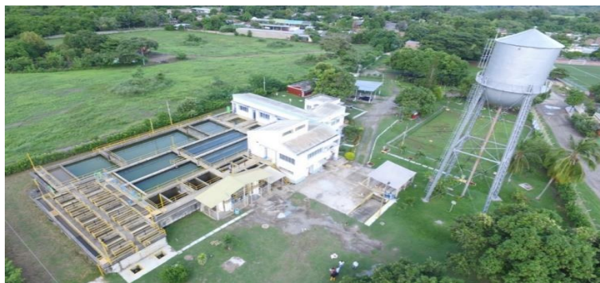
Figura 5. Planta de tratamiento de agua potable EAAA
