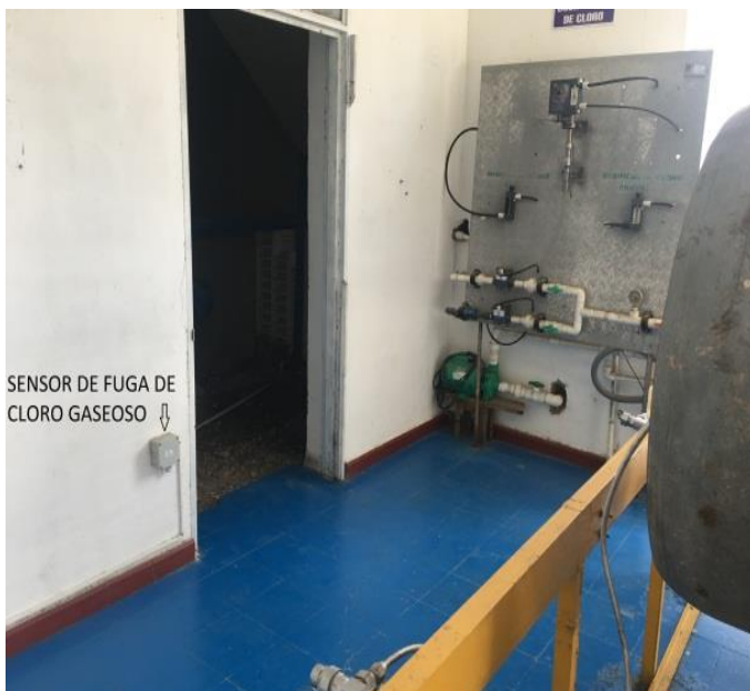
FOTOS ALARMA DE EMERGENCIAS FUGA DE GAS CLORO - PTAP
