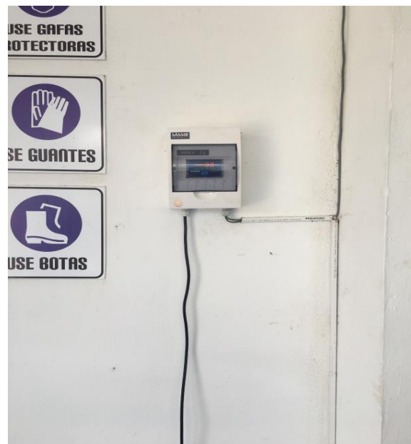
FOTOS ALARMA DE EMERGENCIAS FUGA DE GAS CLORO - PTAP
