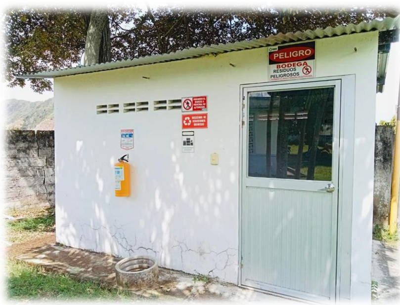
Ilustración 13. Centro de acopio de residuos peligrosos PTAP
